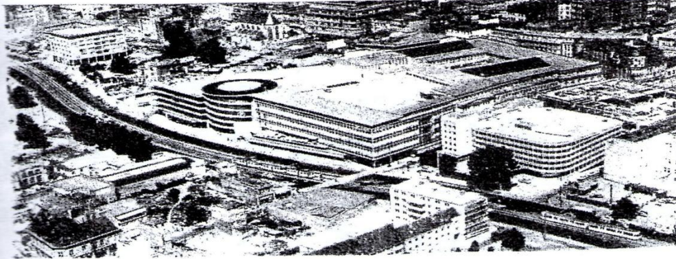
Круглая рампа гаража при университете в г.Кельне обогащает градостроительную ткань рядовой застройки
