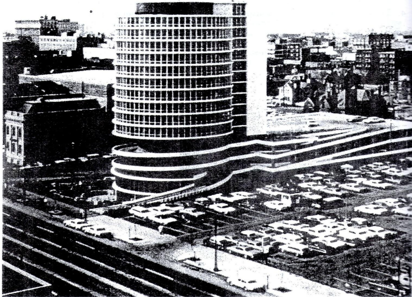
Фирма «Карлсберг энд ассошиейтс». Отель «Христофер инн» Охайо (1963). Просторная стоянка для автомашин со спиральной рампой служит огромным пьедесталом, на котором воздвигнута цилиндрическая башня отеля
