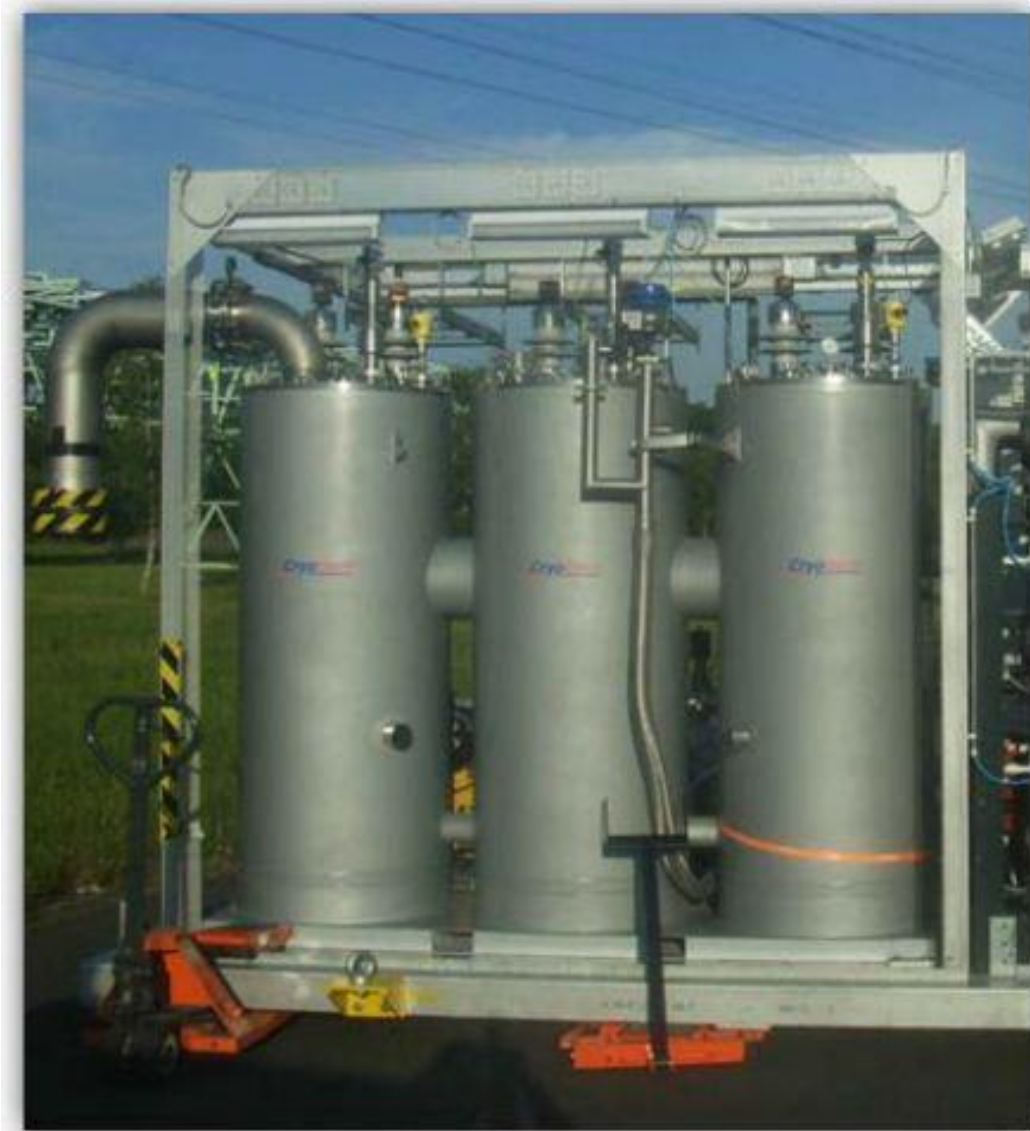
Сверхпроводниковый ограничитель тока От компании NEXANS
