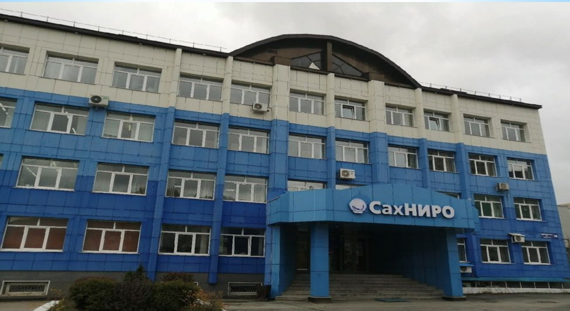
Рис. 1 – Фото здания Сахалинского филиала ФГБНУ «ВНИРО» («СахНИРО»).
