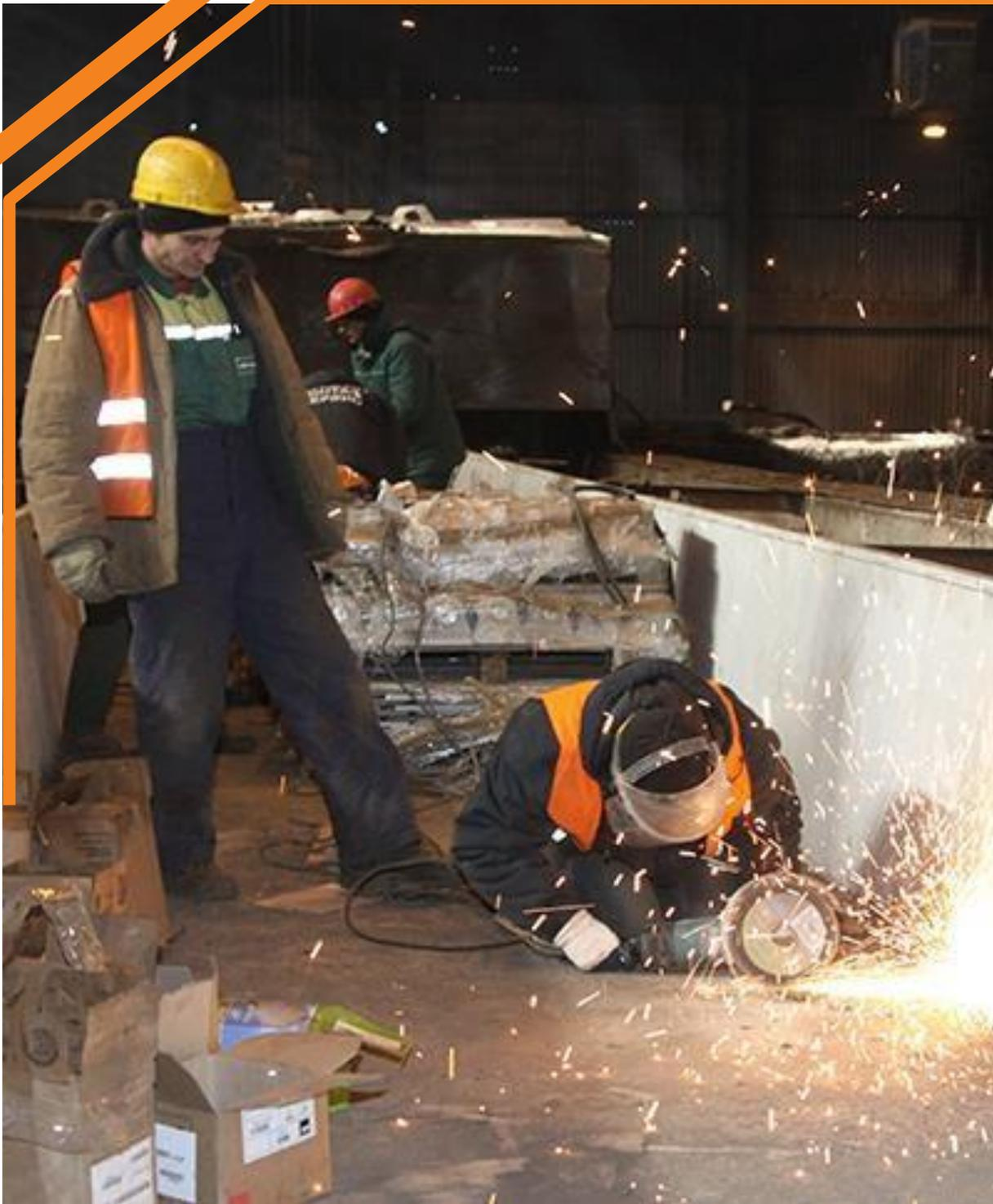
Порядка 70 метров конвейера смонтировали уже с усилением ферм и новыми поддонами, для увеличения скорости и объёма производства.
