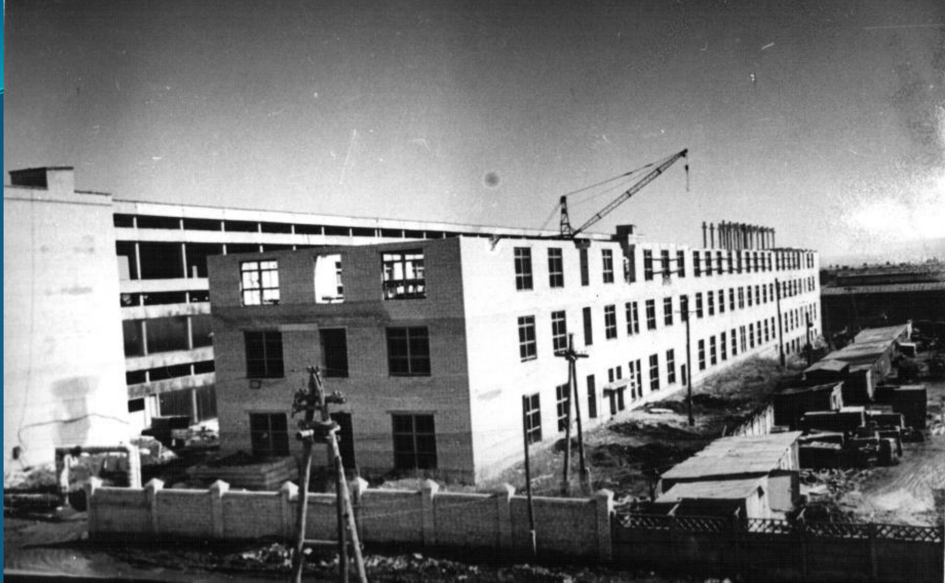
СТРОИТЕЛЬСТВО КОРПУСА №3 САРАНСКОГО ПРИБОРОСТРОИТЕЛЬНОГО ЗАВОДА. 1970 г.
