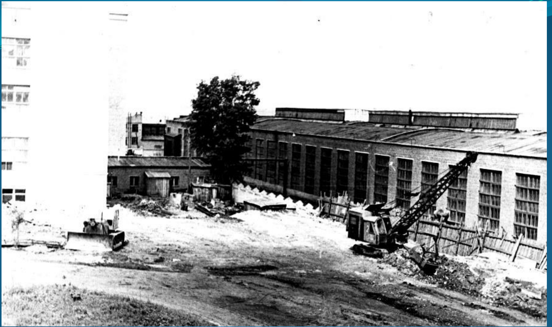
НАЧАЛО СТРОИТЕЛЬСТВА ИНЖЕНЕРНОГО КОРПУСА САРАНСКОГО ПРИБОРОСТРОИТЕЛЬНОГО ЗАВОДА. 1970–е гг.
