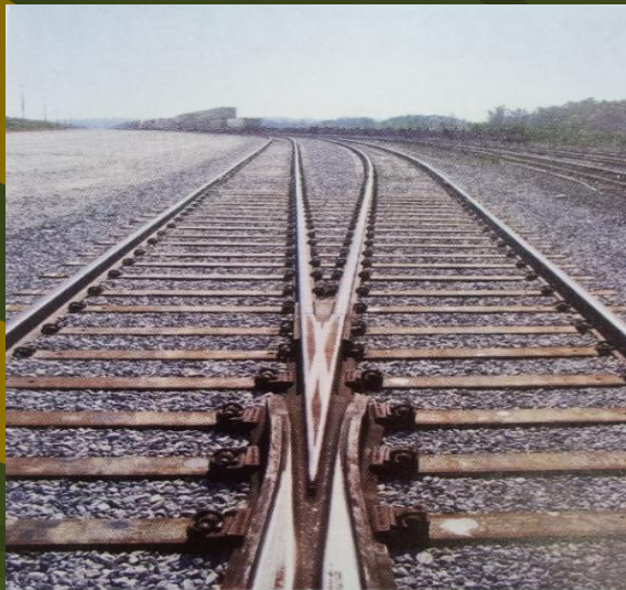
Рис. 3. Путь на стальных шпалах компании NARSTCO
