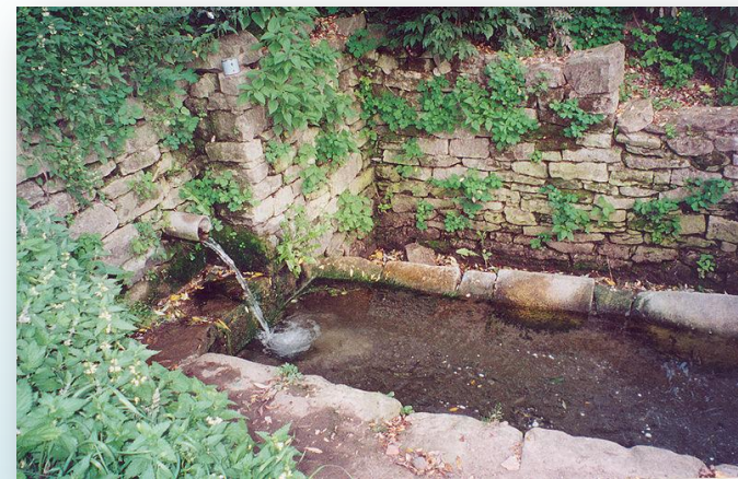
Шипот — подземный источник водоснабжения
